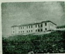
Pazarvıran yeni okulu No: 2 a Bölge köy okulları binaları bölge çevresi içine giren köylerdeki halkın inşaat işlerinde çalışmalarile kurulmaktadır. Temeli kazan, inşaat malzemesini taşıyan, dıvarı ören, kiremidi yapan, taşı yontan, kireci hazırlayan, sıvayı perdeliyan, iş yapabilme kudretini taşıyan büyüklü küçüklü, kadımlı, erkekli köylülerdir. Yalnız marangozluk işleri için şehirlerden ustalar getirilmiş; cam, boya, kilit gibi köyden tedarik edilemeyen malzeme köy sandıklarında okul için
